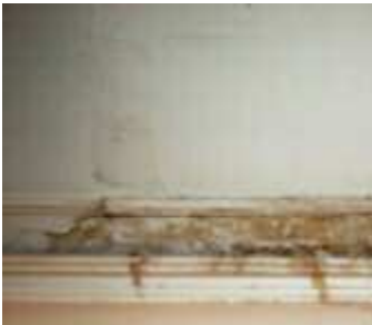
Setzungsrisse und Feuchtigkeitsschäden im Deckenbereich
